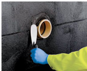
Řešení prostupů při netlakové vodě.
